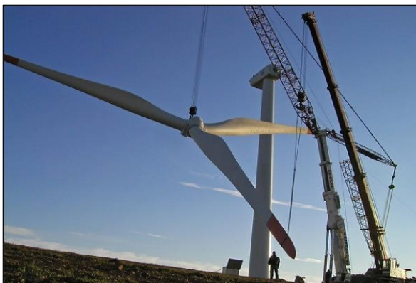
Figuur 13 : Plaatsing hub met wieken
