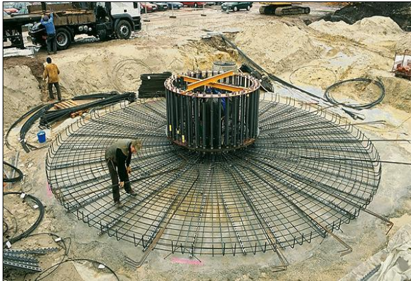
Figuur 11 : Fundering windturbine
