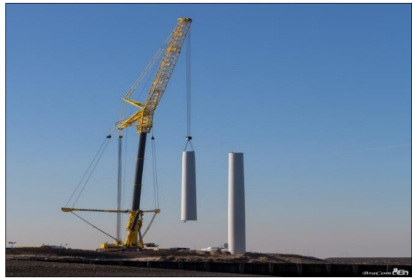
Figuur 12 : Bouw mast windturbine
