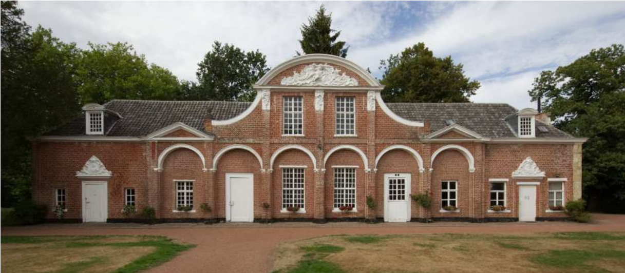
zuidgevel bijgebouw noord
