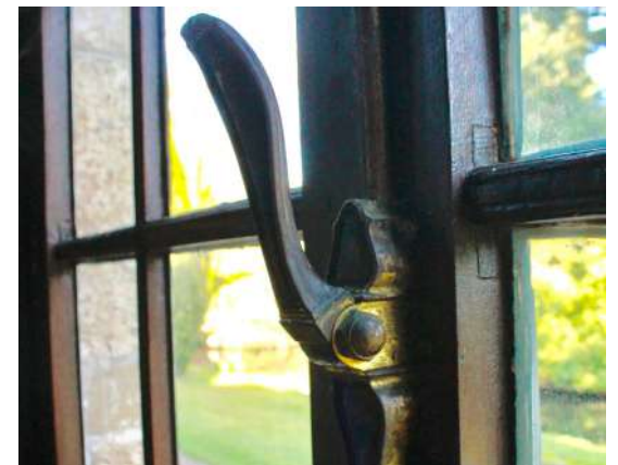
gelijkvloers - spanjoletten ramen
