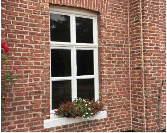
zuidgevel bijgebouw noord
