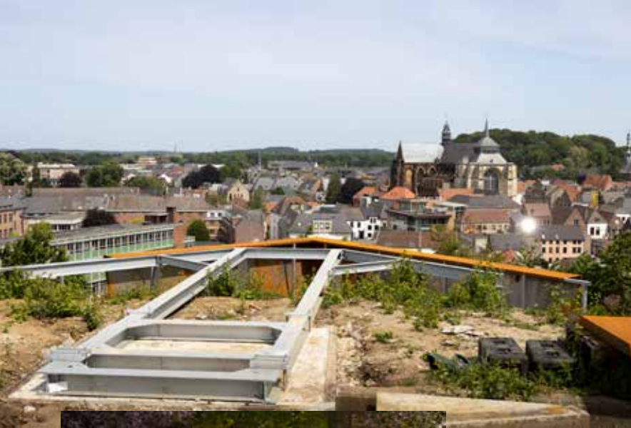
Ter hoogte van het verdwenen noordelijke bastion wordt een panoramisch uitkijkplatform gebouwd dat verwijst naar de oorspronkelijke vorm.
