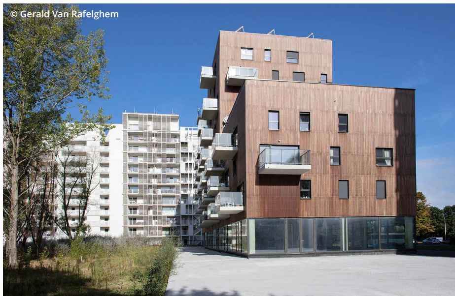
▲ De site bleek een ideale locatie voor stedelijke verdichtingen. Vandaar dat er een extra woonblok met 32 appartementen werd gebouwd.
