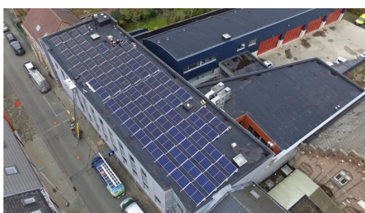
Sint-Annasite, Opwijk (03/2021) 114 panelen, 51 kWp Jaarlijkse productie: 46 MWh Jaarlijkse CO 2 besparing: 12 ton
