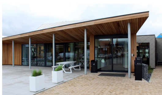
WZC Molenstee, Kampenhout (04/2021) 216 panelen, 117 kWp Jaarlijkse productie: 95 MWh Jaarlijkse CO 2 besparing: 25 ton
