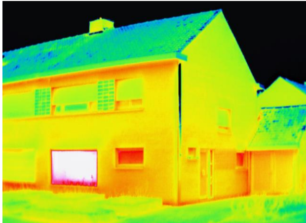
Warmtecamerabeelden – eigen werk
