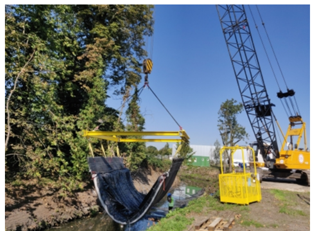
Figuur 16a: schematische voorstelling en 16b: plaatsing reactieve matten in de Lieve, Gent (bron: Resanat)
