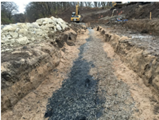
Figuur 19: Permealabele reactieve wand met organoklei (bron: AquaBlok Ltd.)
