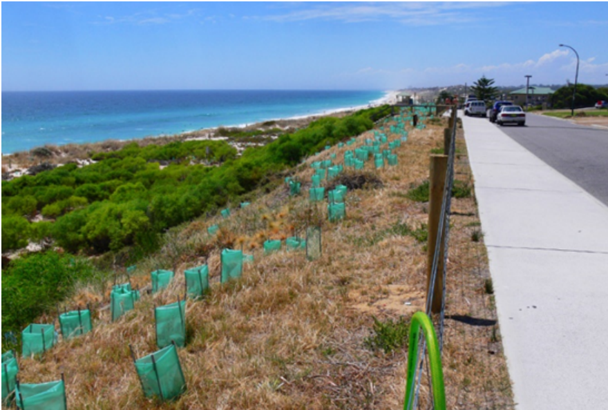
Figuur 4: Beplanten van een steile helling naast een autoweg.
