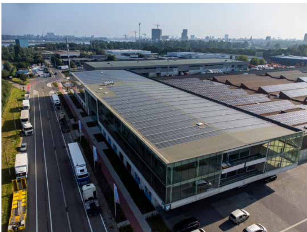
Lichtgewicht zonnepanelen omzeilen mogelijke problemen met stabiliteit bij bedrijfsgebouwen (foto: Groothandelsmarkt Antwerpen).
